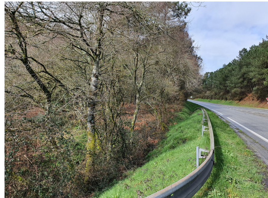
7. Fossé profond et talus haut mettent la D769 à distance
