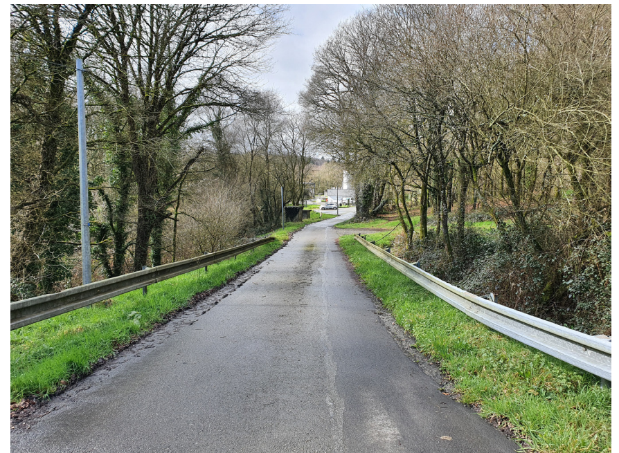
3. Voirie de desserte vers le site, au loin la Station d'épuration
